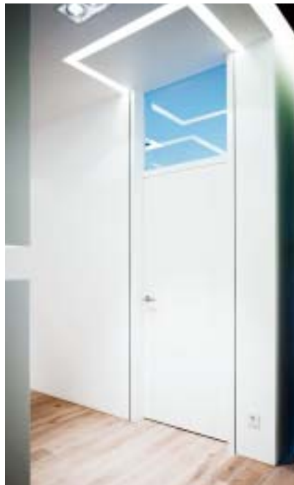
Die an das Oberlicht anschließende u-förmige Lichtvoute erweitert die Tür zum Raum
