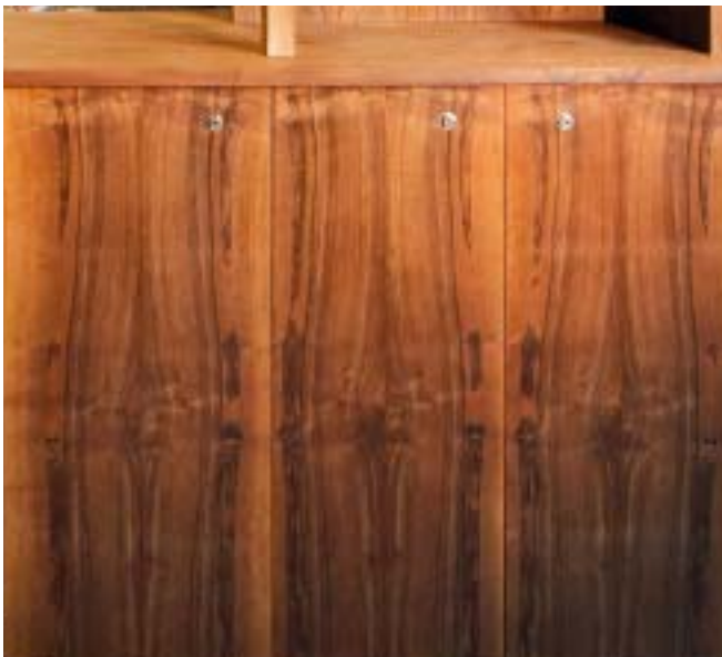
Maßarbeit: Die insgesamt über 15 Meter breite und gespiegelte Furnierabwicklung passt sich in die Aufteilung der Einbauschränke ein
